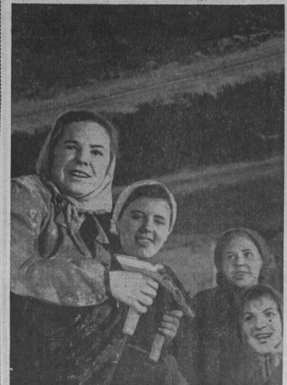
Зоя Литкина работает во втором стройуправлении треста «Кемеровоугольстрой». Она опытный штукатур. Часто она делится своим опытом с молодыми работниками.
