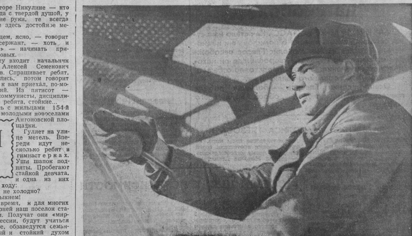
На монтаже мощного крана БК-1000 на Запсибе работает бригада коммунистического труда В. Н. Онойченко. Кран монтируется у 1-й доменной печи и будет служить основным средством ее монтажа. Его грузоподъемность 80 тонн. Это первый кран в стране, применяемый для монтажа таких мощных сооружений. На снимке: монтажники И. И. ПОЛЯКОВ из бригады В. Н. ОНОЙЧЕНКО на монтаже стрелы крана. Фото А. Воинова.
