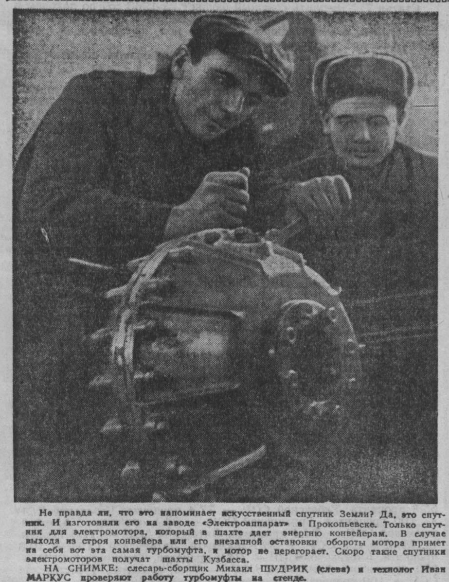
Не правда ли, что это напоминает искусственный спутник Земли? Да, это спутник. И изготовила его на заводе «Электрощахта» в Прокопьевске. Только спутник для электромотора, который в шахте дает энергию комбайнерам...
