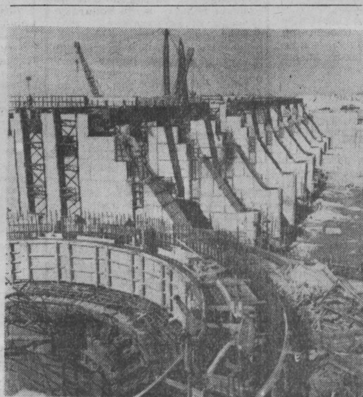
Строители Днепродзержинской ГЭС готовятся к перекрытию Днепра. На стройке это дня в день нарастает трудовой подъем. К 30 октября должна быть затоплена котлована. Досрочно закончены отделочные работы на судостроительном цехе. Он готов под запуск. Быстрыми темпами ведутся другие работы.
