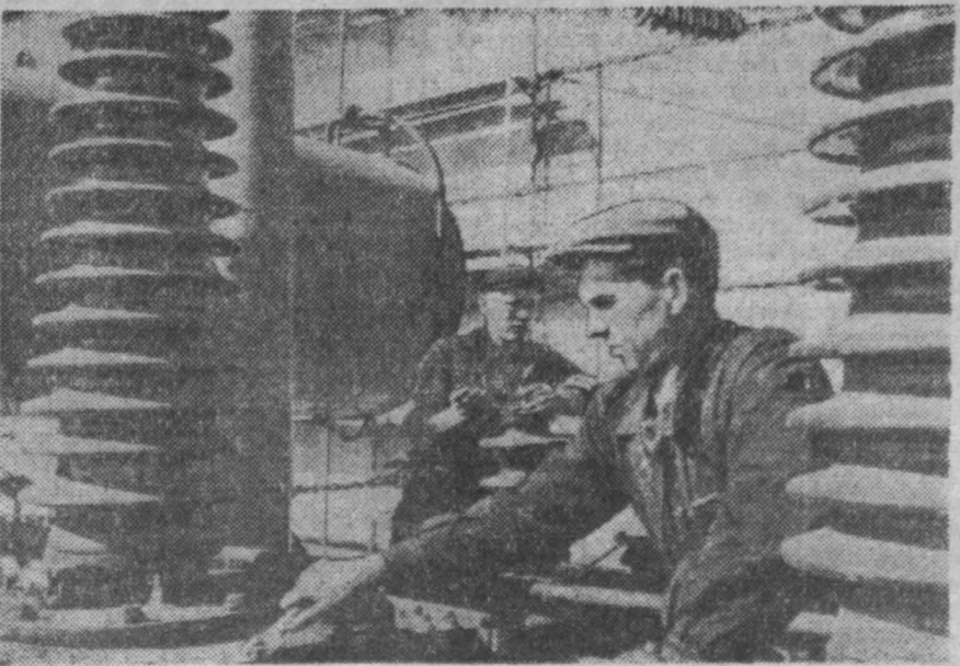
В 1962 году даст первый чугун Заводско-Сибирский металлургический завод. Монтаж домы уже начался. Но раньше все должны встать в строй десятки других объектов, в частности ТЭЦ, коксовые батареи, агломерационные печи.
