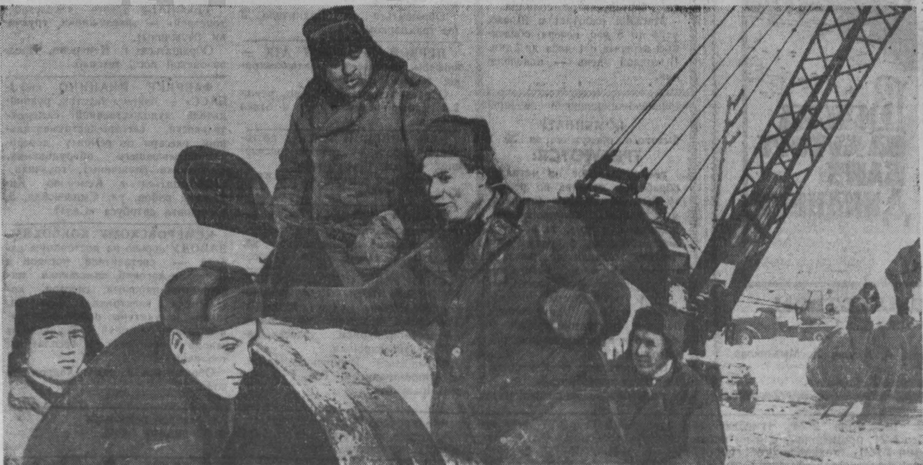
НА СНИМКЕ: бригада Костромин на укладке труб.
