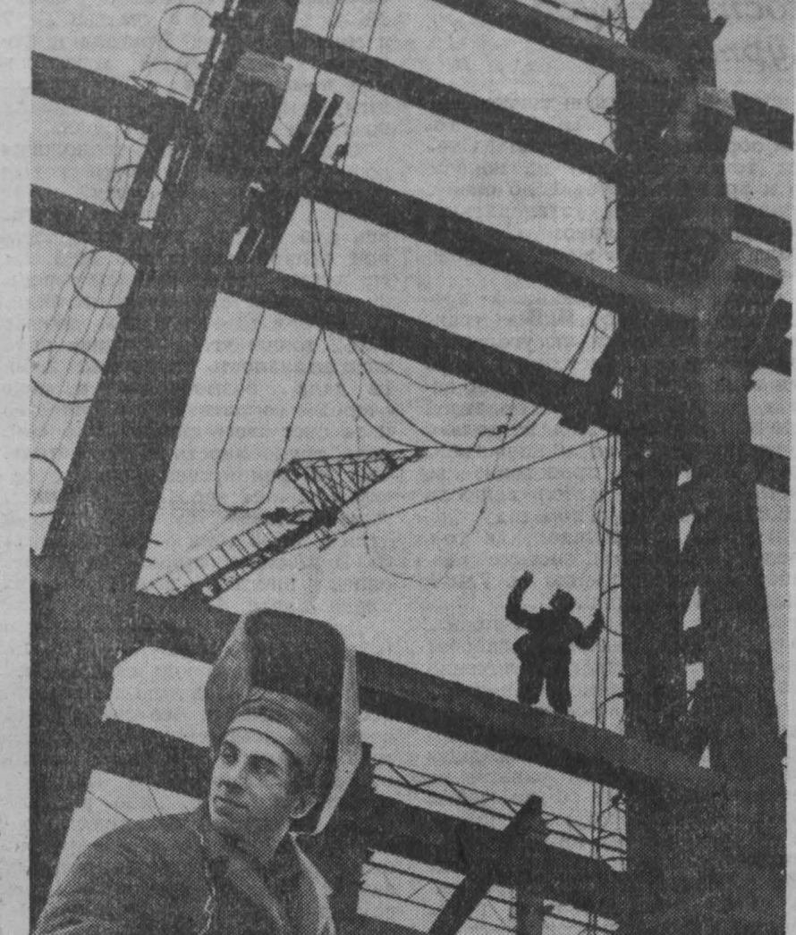
Монтажники-высотники. Их руками уложены сотни железобетонных балок, панелей, перекрытий. На сборке главного корпуса Беловской ГРЭС трудятся комсомольцы, молодежь, прибывшая на строительство гиганта энергетики со всех концов нашей Родины.
