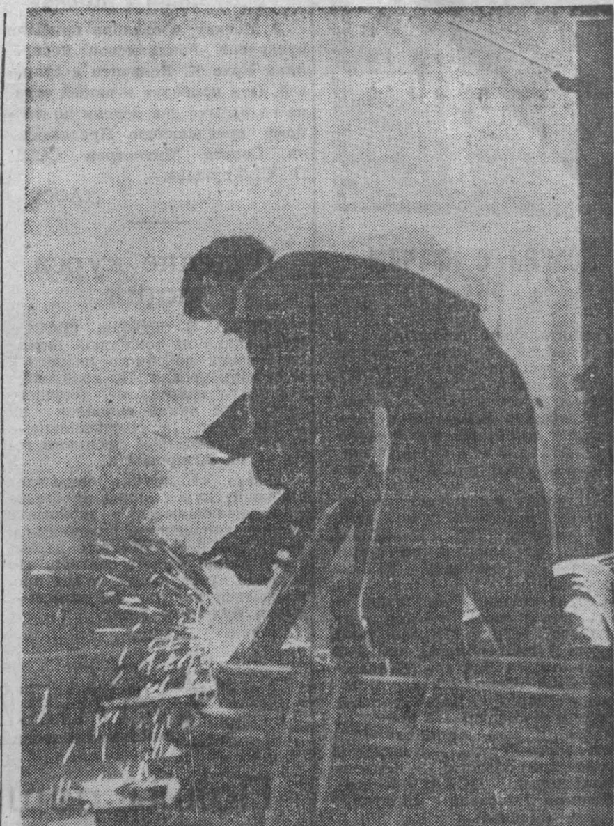
Начался трудовой день. Яркими искрами засветился цех металлоконструкций. Сюда пришли сварщики. Завод «Строймаш».
