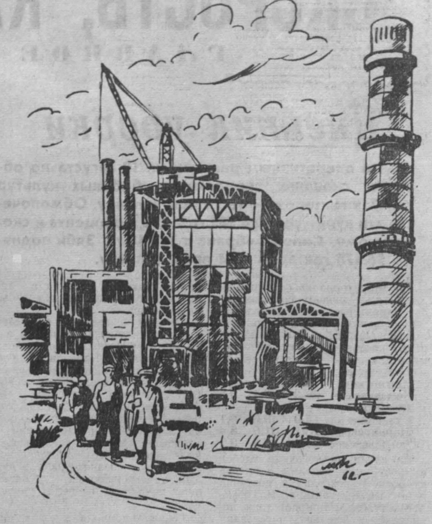
На строительстве Ново-Кемеровской ТЭЦ.
