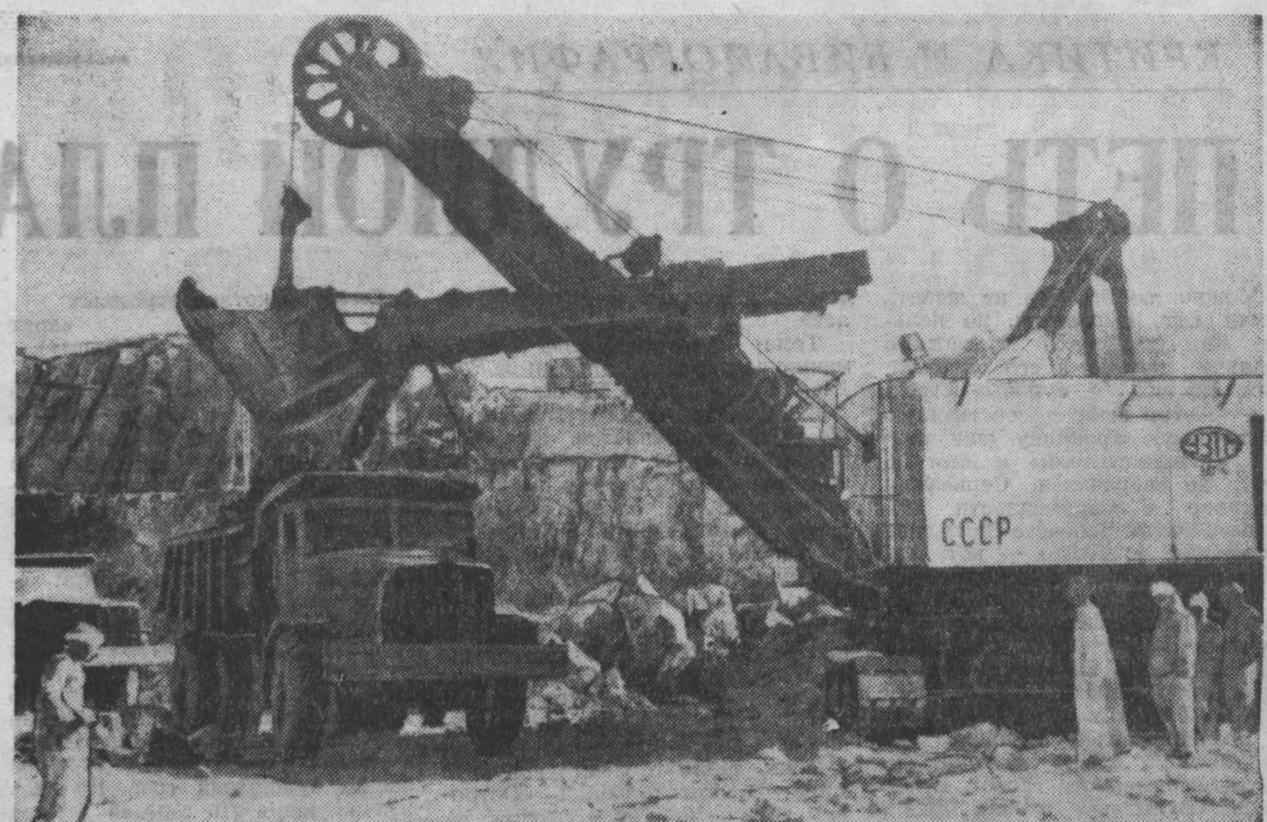
В Объединенной Арабской Республике при технической и финансовой помощи Советского Союза сооружается высокая Асуанская плотина. На строительстве гидротехнического гиганта широко используются современное советское оборудование, механизмы и материалы. На снимке: экскаватор «ЭКГ-4» производит выемку крепчайшей асуанской скалы — гранитов на месте будущего водостоящего канала. Фото Централькино — ТАСС.
