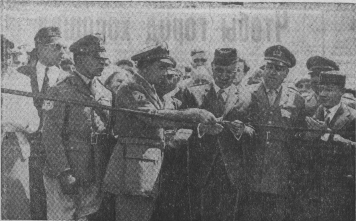
При технической помощи СССР в Афганистане сооружается самая крупная в стране автомобильная дорога с цементно-бетонным покрытием. Кушка — Герат — Кандагар протяженностью 678 километров. Дорога, имеющая большое экономическое значение, прокладывается в резко пересеченной местности. Недавно на строительстве побывал король Афганистана Мухаммед Захир Шах. Он остался доволен ходом работ и выразил благодарность Советскому Союзу за бескорыстную помощь афганскому народу. На снимке: король открывает движение по новому 410-метровому мосту через реку Тиринд в Герате. Фотохроника ТАСС.
