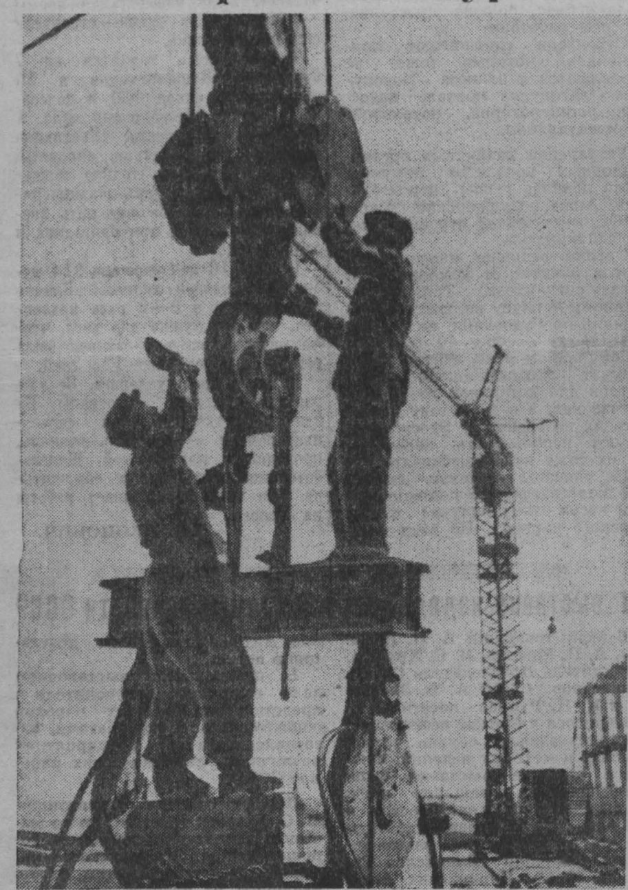
На строительстве Беловской ГРЭС. Фото Л. Удовиченко.
