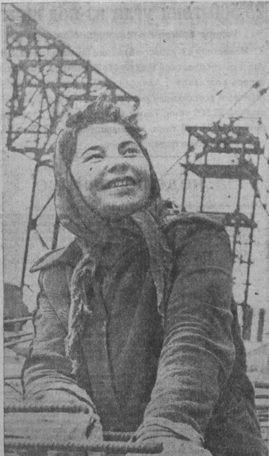
Отлично работает комсомолка Валентина Гориславская из шестого строительного управления треста «Кузнецкметаллургстрой» на строительстве Зависа. В эти дни она трудится на коксовом — пусковом объекте нынешнего года. Фото В. Ларина.
