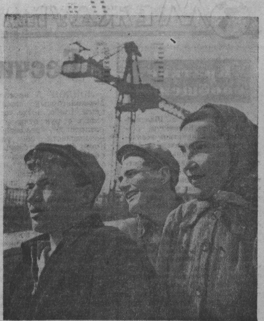
Бригада коммунистического труда Алексея Антонова из СУ-2 треста «Кемеровоугольстрой» заканчивает кладку новой большой школы на ул. Красноармейской. Молодежь постоянно выполняет сменные нормы. На снимке: заместители бригады Терман Топтыгин, Петр Шувалов и Надежда Козлячкова.
