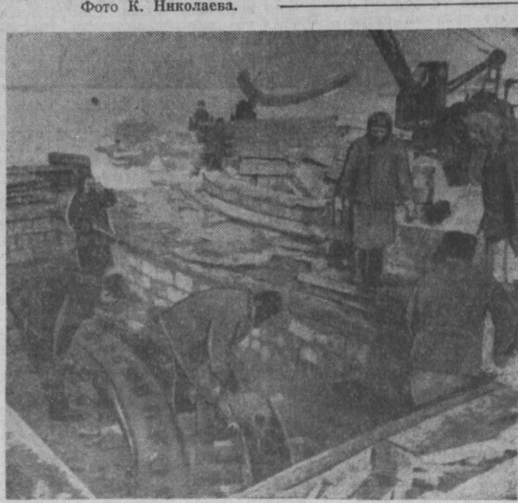
НА СНИМКЕ: Судженская РТС, пропарочная камера, в которой изготавливаются полуарки для скотных дворов. Фото К. Николаева.
