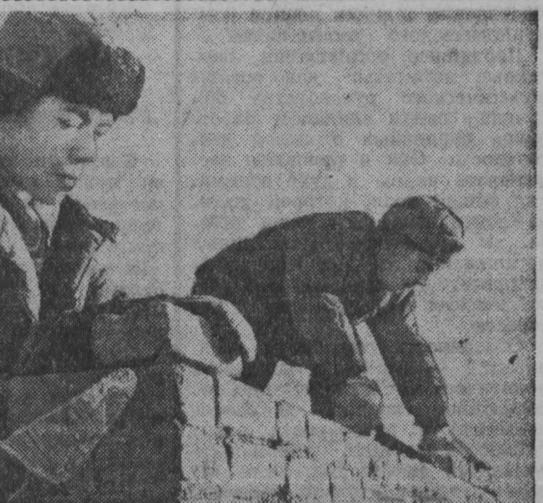
Комплексная бригада Ш. Абдулина из треста «Сталинскромстрой» ведет строительство завода гудронетов домостроения и канализационных труб.
