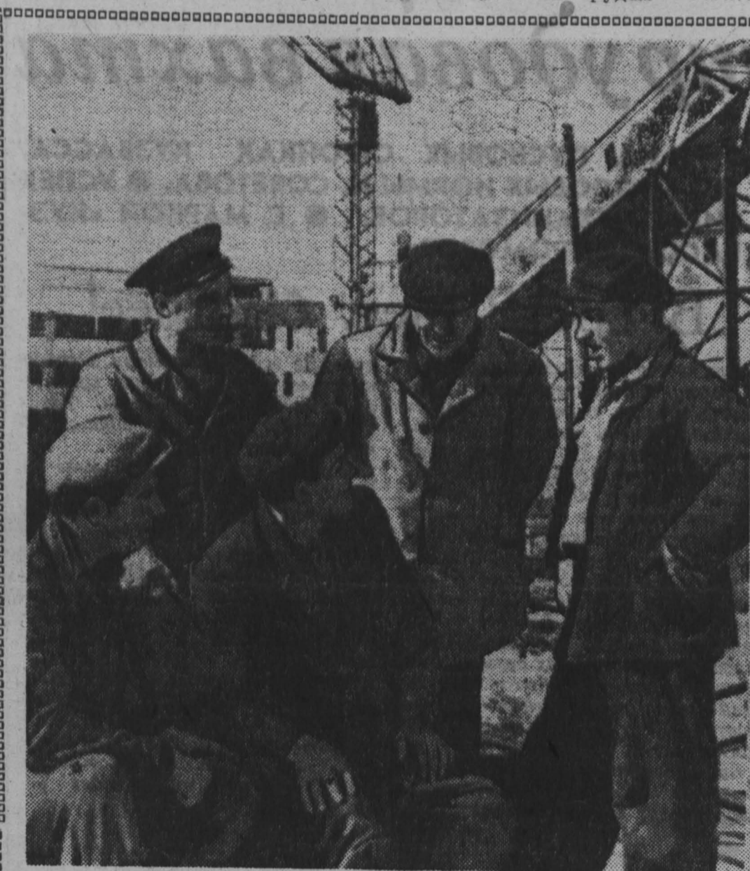
Бригада монтажников во главе с А. В. Ивановым — одна из лучших на Зависии. Работая на сооружении Дробильной фабрики, она стремится сдать первую очередь предприятия к открытию XXII съезда партии. В эти дни монтажники выдают свое задание на 140—150 процентов.
