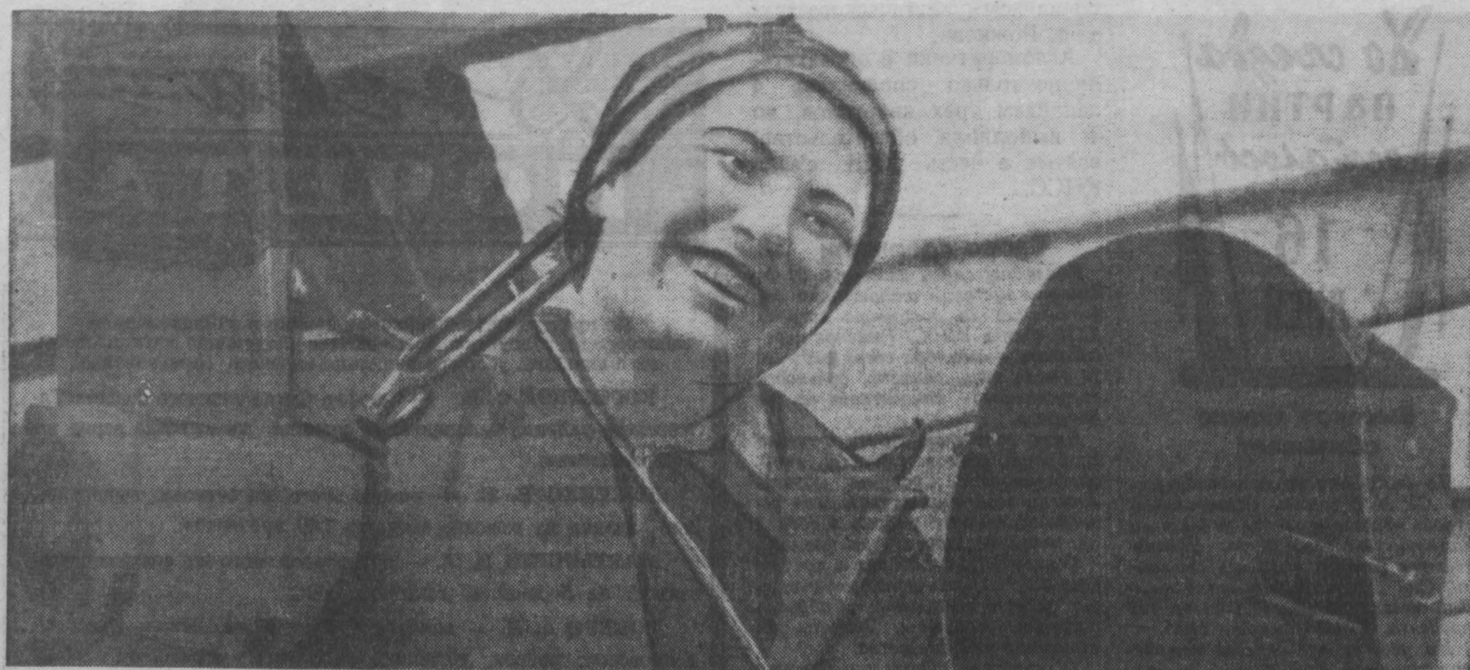
Это Шура Мочалова. Она электросварщица СМУ-2 треста «Сибметаллургомонтаж». В предсезонские дни все свое старание и умение комсомолка отдает тому, чтобы быстрее встал в строй ударный объект № 1 — новая котельная на Запсибе. Ее электроды навски соединяют конструкции пятого котла.
