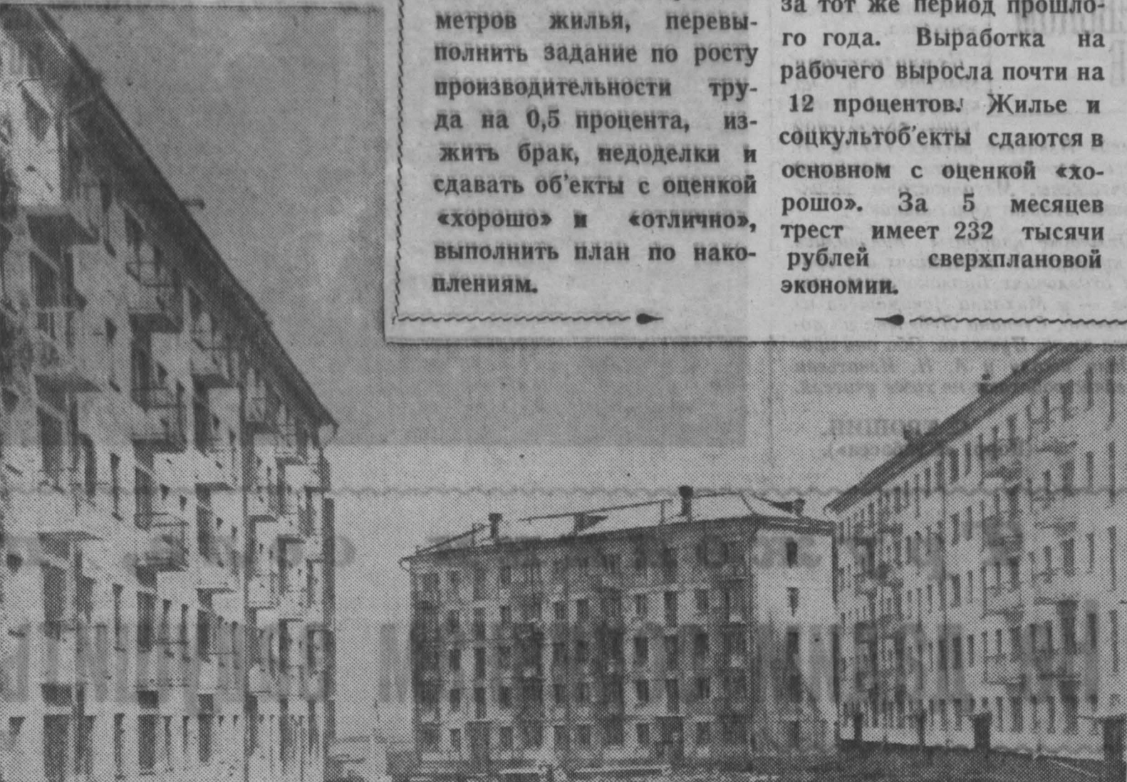
Это один из уголков жилого поселка строителей Завсиды с левой стороны железнодорожного полотна. Его строят рабочие треста «Кузнецкжилстрой».
