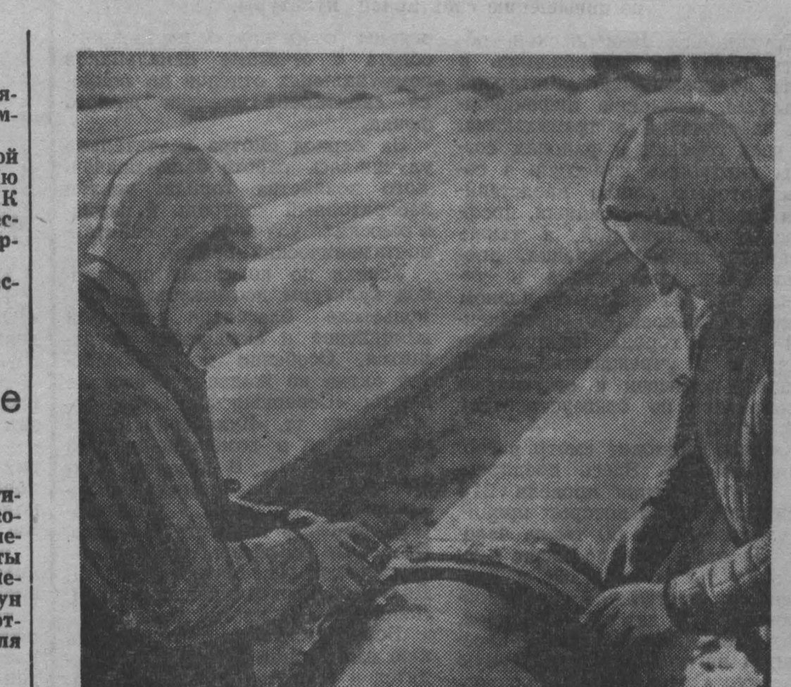
В Польской Народной Республике успешно проводится строительство нефтепровода Дружба, по которому будет доставляться ценное сырье из далекого Куйбисева на Волгу. В будущем польские предприятия будут ежедневно перерабатывать 6 миллионов тонн импортной нефти. НА СНИМКЕ: прокладка труб в районе Лодзь. Фотохроника ТАСС.
