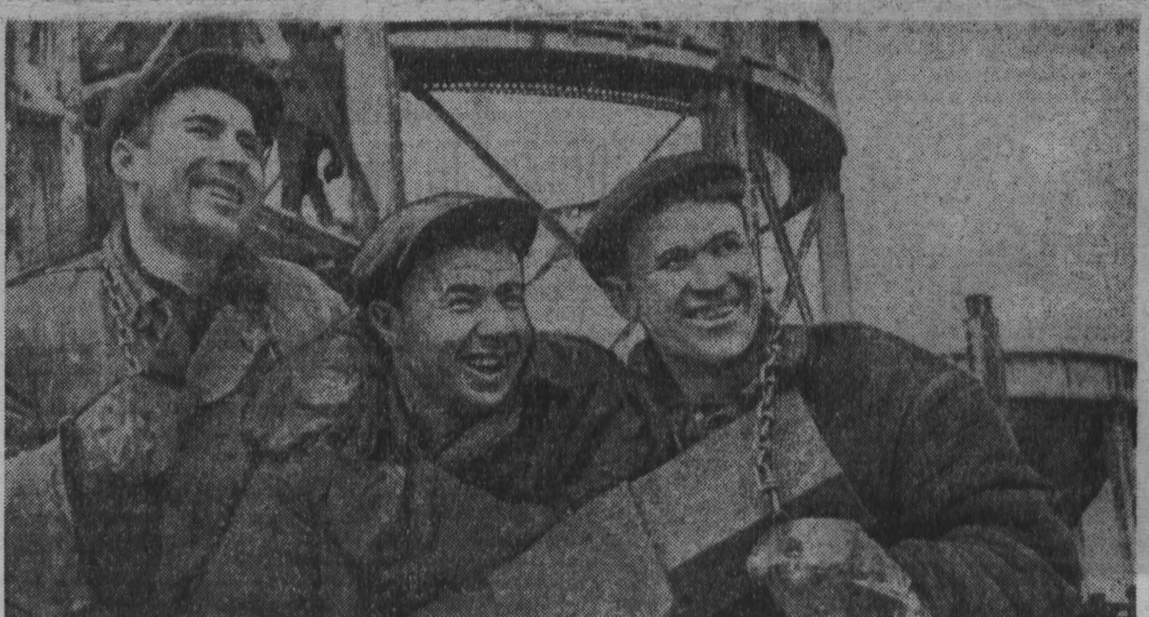
НА СТРОИТЕЛЬСТВЕ Западно-Сибирского металлургического завода монтажники бригады Виктора Григорьевича Кондратьева работают с первым блоком. Они установили в сооружении первого бетонорастворного завода, центральной котельной, бойлерной.
