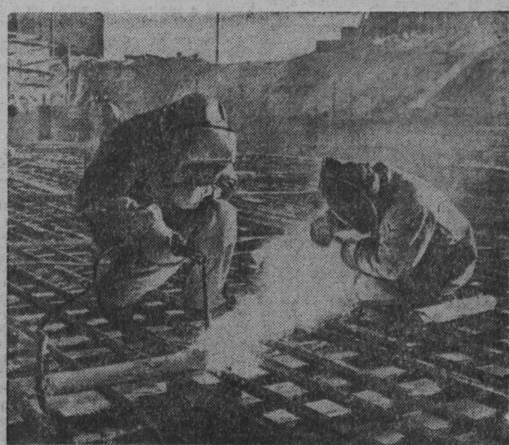
На Новолипецком металлургическом заводе началось сооружение новой домы. Стройка объявлена ударной комсомольской. Строители обязались завершить ее в 1961 году. Сейчас сооружаются фундамент и поддон домы. На снимке: на строительстве новой домы. Фотохроника ТАСС.
