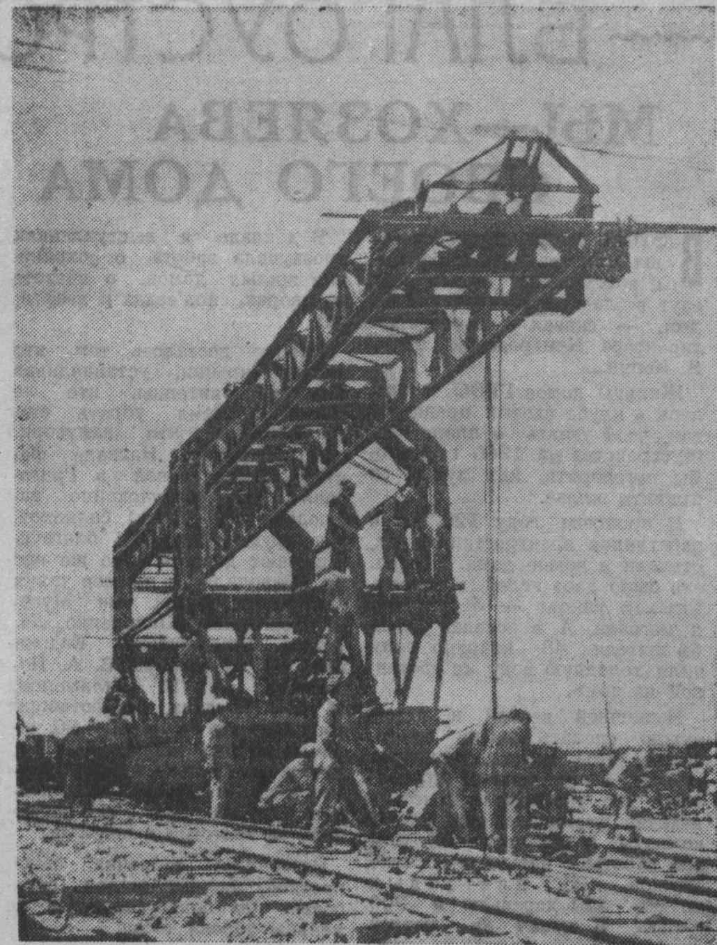
Китайская Народная Республика. На южном участке строительства Нейцзян-Куньминской железной дороги в близлежащее время начнется укладка рельсов. На снимке: подготовка путевых укладчиков к работе.
