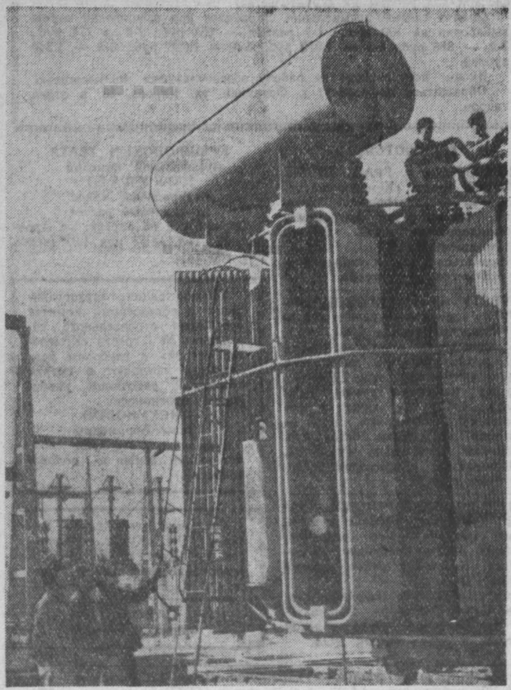
Китайская Народная Республика. Монтаж трансформатора на электростанции обогатительной фабрики на железорудном месторождении Дае (Центральный Китай).
