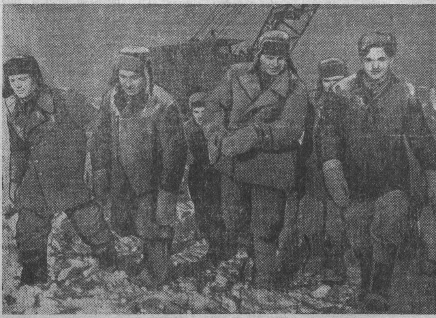
В четвертом стройуправлении треста «Сталинскметаллургстрой» организована новая комплексная комсомольская бригада. Она состоит из демобилизованных воинов. Возглавляет бригаду Еким Келин (второй слева). Сейчас эта бригада успешно трудится на сооружении фундамента цеха металлоконструкций будущего Западно-Сибирского металлургического завода. НА СНИМКЕ: бригада Келина после смены.
