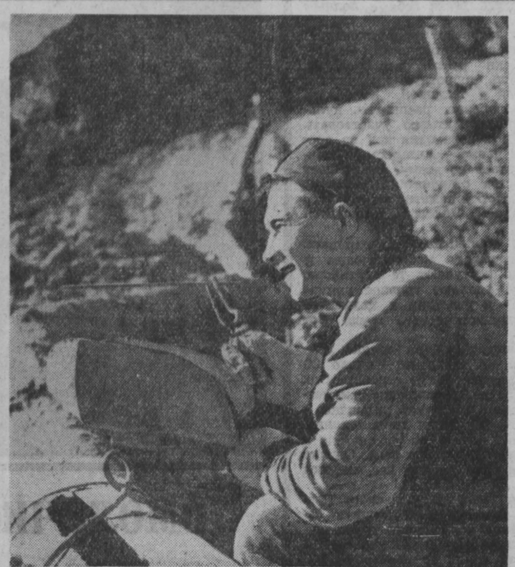
НА СНИМКЕ: И. Тарханов, онытный газосварщик участка № 7 Кедровского угольного разреза. Своим трудом он помогает гидромониторщикам вести вскрышку. Нарращивание и демонтаж трубопровода — его основная работа, которую он всегда выполняет добросовестно.
