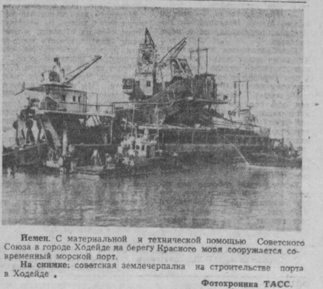
Именем С материальной и технической помощью Советского Союза в городе Ходейде на берегу Красного моря сооружается современный морской порт. На снимке: советская землечерпалка на строительстве порта в Ходейде. Фотохроника ТАСС.
