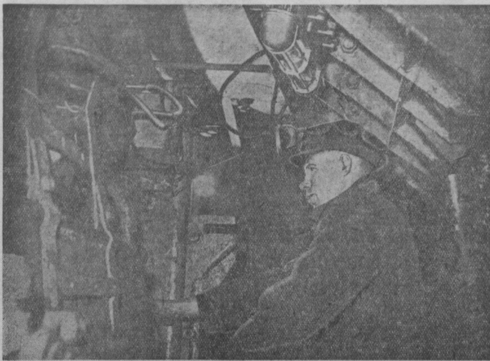
У ПУЛЬТА УПРАВЛЕНИЯ агрегата «А-3» – шахтер. Легкое прикосновение рукой — и машина приходит в движение. Ее рабочие органы скальвают уголь по всей длине лавы, транспортируют его к местам погрузки. По мере продвижения забоя автоматически движется гидрофицированная металлическая крепь.
