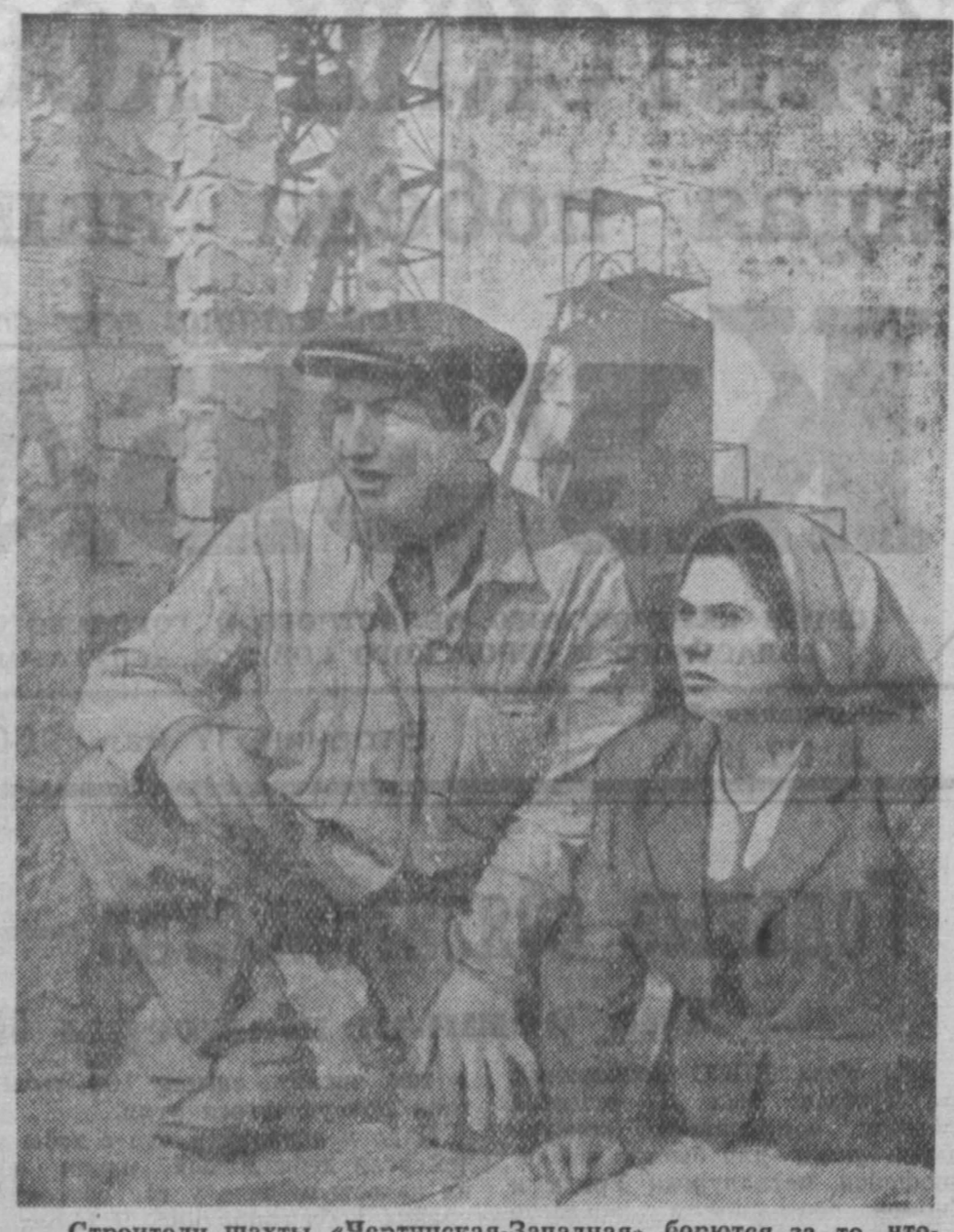
Строители шахты «Чертлинская-Западная» борются за то, чтобы к 7 ноября ввести новое угольное предприятие в строй действующих. Отлично трудится на стройке комплексная бригада А. Гордеева.
