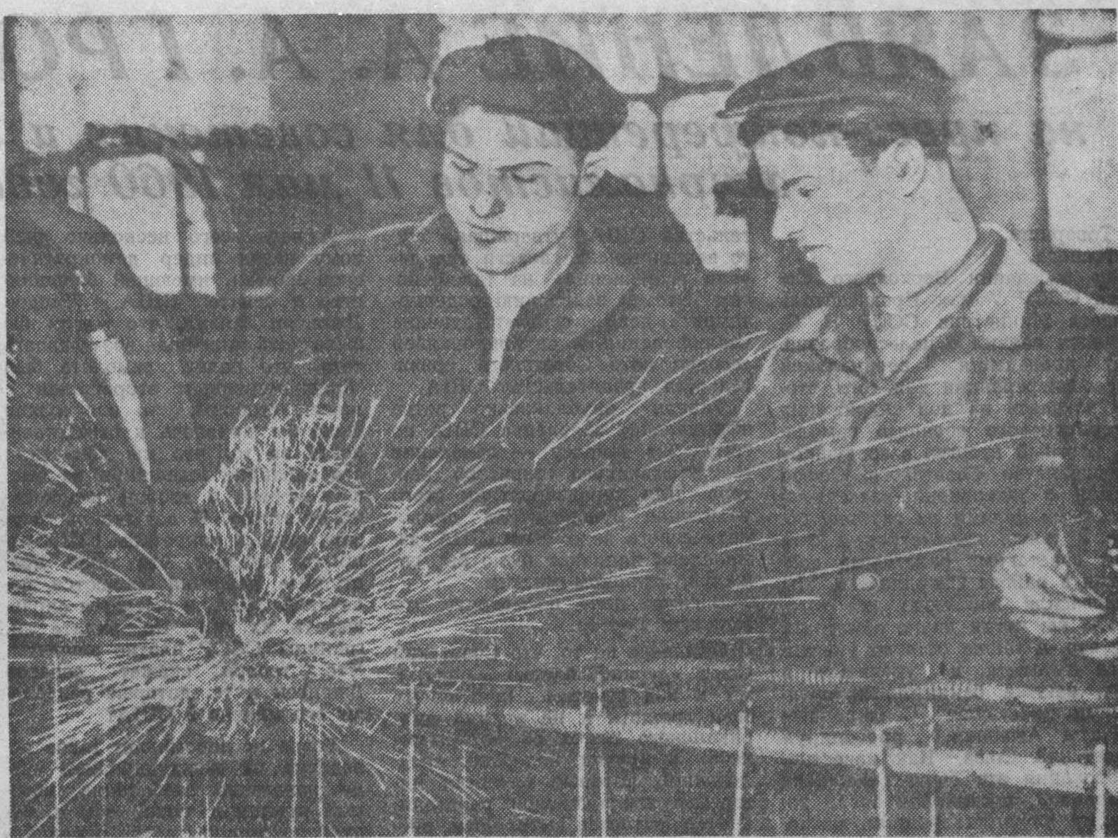
МНОГИЕ комсомолы, бывшие воины Советской Армии, приехали в Кузбасс на стройки и заводы. Среди них и Василий Полятрава. С шестью солдатами своей части он прибыл на Сталинский завод железобетонных конструкций № 3 треста «Стройиндустрия». Был два месяца учеником, а сейчас работает арматурщиком, одновременно учится на сварщика. Практику проходит у сварщика Сергея Гусакова. НА СНИМКЕ: В. Гусakov и В. Полятрава за сваркой арматуры. Фото П. Костюкова.
