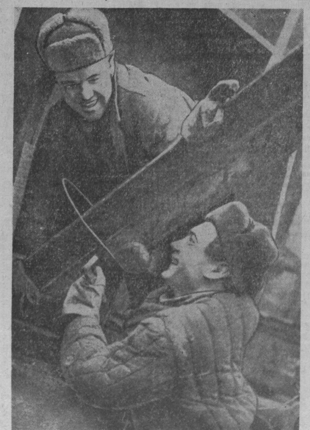
Как можно раньше слать Кузнецкую домну в эксплуатацию — под таким лозунгом трудятся сейчас молодые монтажники Виктор Пуртов и Валерий Пономарев. Они выполняют по полторы с лишним нормы в смену. Умелыми руками этих ребят смонтированы сотни тонн металлоконструкций. НА СНИМКЕ: Виктор ПУРТОВ (вверху) и Валерий ПОНОМАРЕВ. Фото А. Кузнецова.
