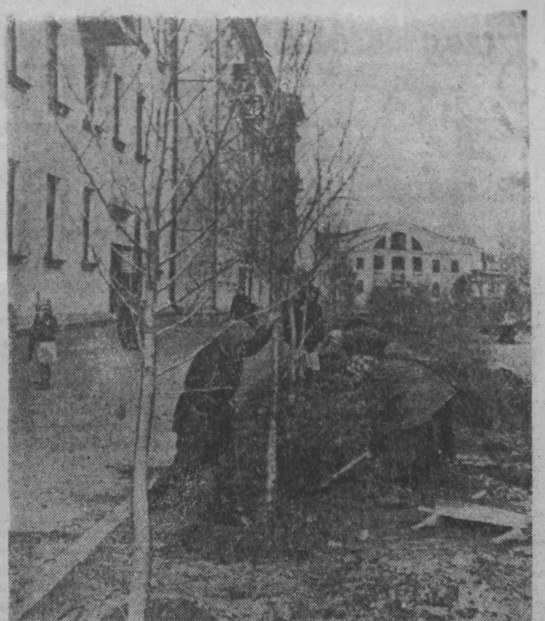
— План месячника по озеленению областного центра трестом «Горзелстрой» выполнен, — говорит директор треста И. Пронинкова. — Но посадки будут проводиться до 5 ноября.
