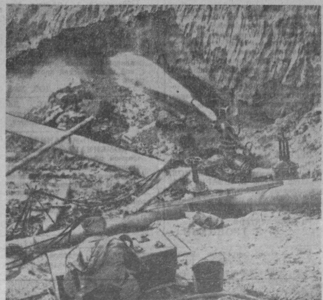
НА СНИМКЕ: гидромонитор за работой.
