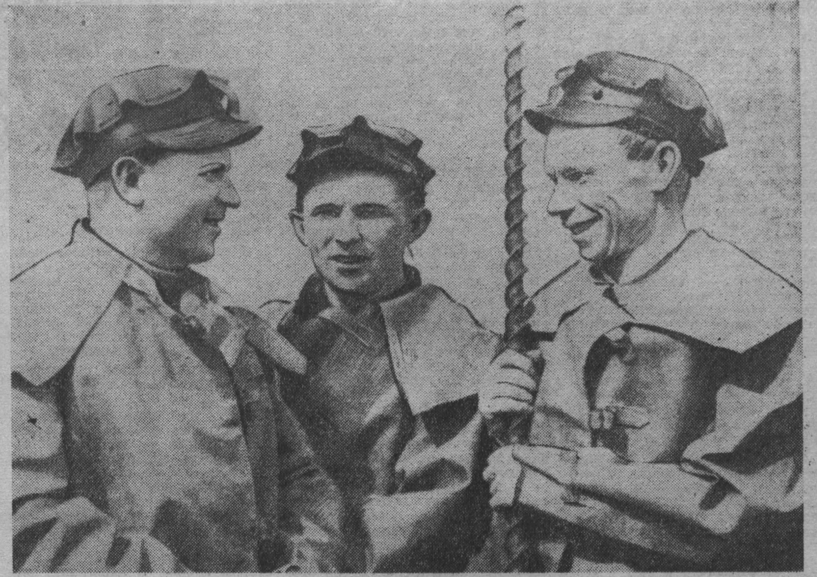
Сталинка. Недалеко от строительной площадки Западно-Сибирского металлургического завода сооружаются гидрошахты «Байдаевские» № 1 и № 2. Эти угольные предприятия поставят топливо будущему гиганту металлургии. Уголь, добываемый водой, будет доставляться по специальным трубопроводам непосредственно на завод. НА СНИМКЕ (слева направо): бригадир И. Е. СИЗЫХ и проходчик А. К. РЕБЕР и И. Н. КРЫЛОВ. Фото В. Скоробогатова.
