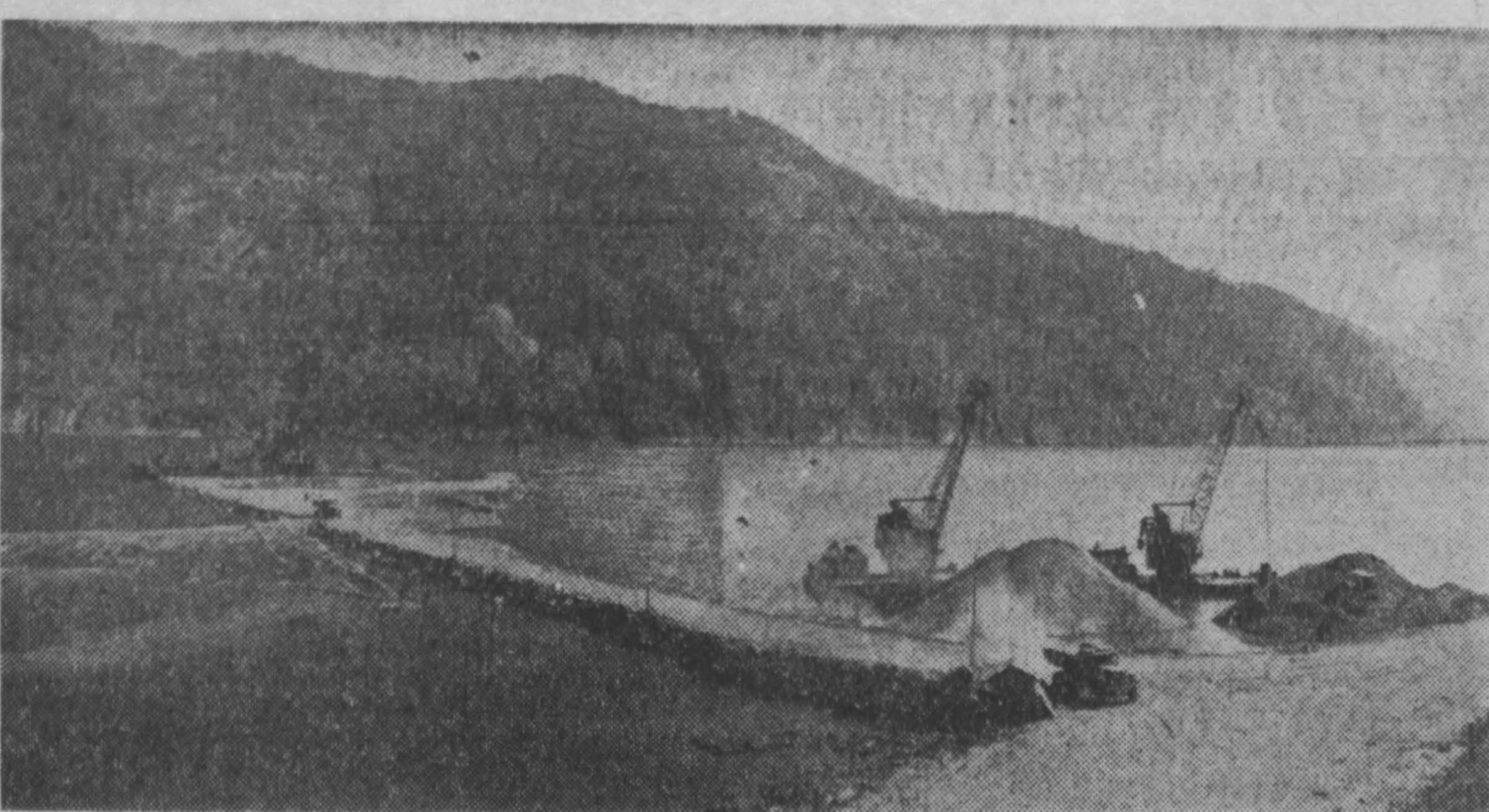
НА СТРОИТЕЛЬСТВЕ КРАСНОЯРСКОЙ ГЭС Строители крупнейшей в мире гидроэлектростанции на Енисее закончили отсыпку банкета поперечной перемычки левобережного котлована. Грязь из камня и гравия доведена до середины реки. НА СНИМКЕ: момент создания каменного банкета верховой перемычки левобережного котлована. Фотохроника ТАСС.
