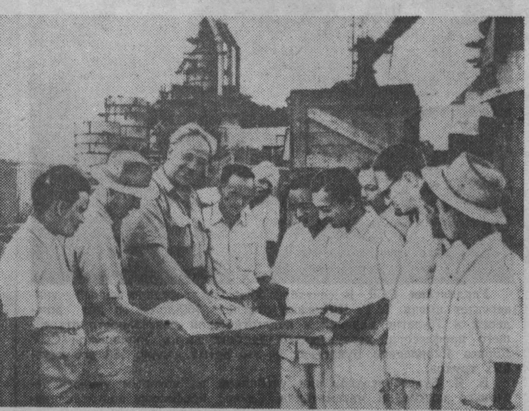
Республика Индия. На строительстве металлургического комбината в Бхилае. Советские и индийские инженеры обсуждают дневное задание.
