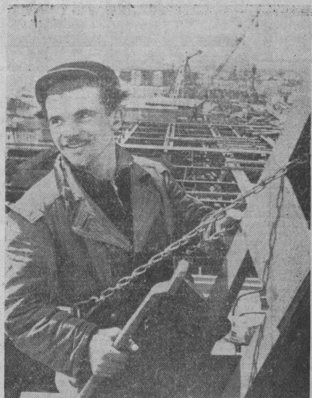
Сталинск. Отличным монтажником зарекомендовал себя Геннадий Федорович Шахов. Работая на сооружении нового моста через Томь, он систематически выполняет по полторы—две нормы в смену.
