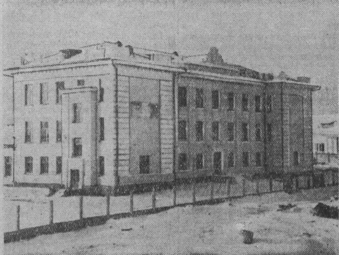
Новая школа в поселке строителей Беловской ГРЭС.
