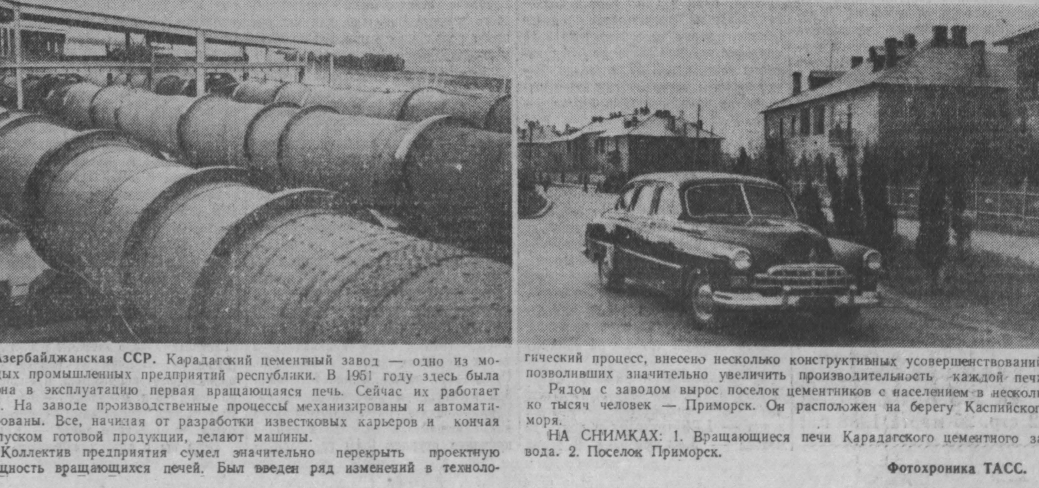
Азербайджанская ССР. Карадагский цементный завод — одно из молодых промышленных предприятий республики. В 1951 году здесь была слана в эксплуатацию первая вращающаяся печь. Сейчас их работает три. На заводе производственные процессы механизированы и автоматизированы. Все, начиная от разработки известковых карьеров и кончая выпуском готовой продукции, делают машины. Коллектив предприятия сумел значительно перекрыть проектную мощность вращающихся печей. Был введен ряд изменений в технологический процесс, внесено несколько конструктивных усовершенствований, позволивших значительно увеличить производительность каждой печи. Рядом с заводом вырос поселок цементников с населением в несколько тысяч человек — Приморск. Он расположен на берегу Каспийского моря. НА СНИМКАХ: 1. Вращающаяся печь Карадагского цементного завода. 2. Поселок Приморск. Фотохроника ТАСС.
