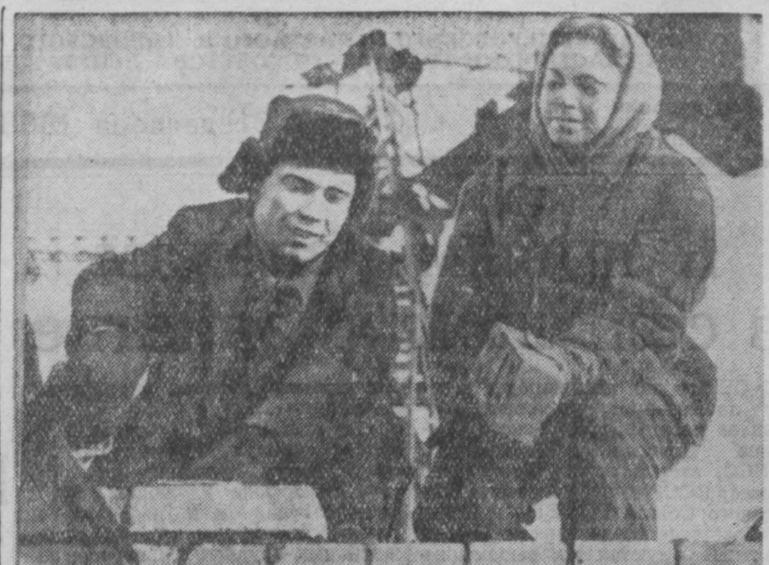
Помогать друг другу, учиться друг у друга — неписанный закон комсомольцев, приехавших на строительство Западно-Сибирского металлургического завода. Выбывшая работница Московского мясокомбината Евгения Грушниковва стала хорошим каменщиком. В этом ей помог Юрий Ваганов. Фото В. Стрельникова.
