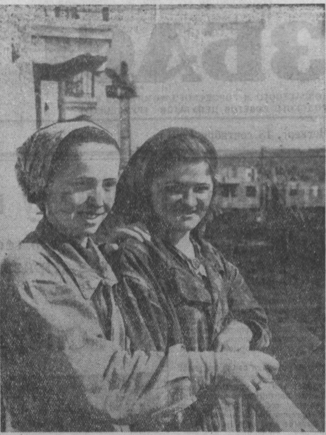
Сталинск. На Ворошиловском шоссе вырос квартал жилых домов из крупных блоков. Скоро в этом районе будет сдано в эксплуатацию 300 квартир. Сейчас ведутся отделочные работы. Штукатурки и маляры строуправления № 1 треста «Сталинскстройтрест» придают этому большому значению. Они прилагают все усилия, чтобы новоселы остались ими довольны.
