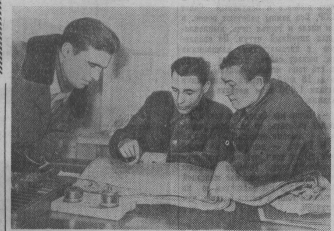
Натяжение арматуры новым способом
