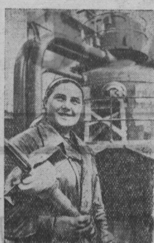
На строительстве Куйбышевской ГЭС подходит к концу отделочные работы здания гидроэлектростанции. Хорошо работает здесь комсомольская бригада Н. М. Конохова.
