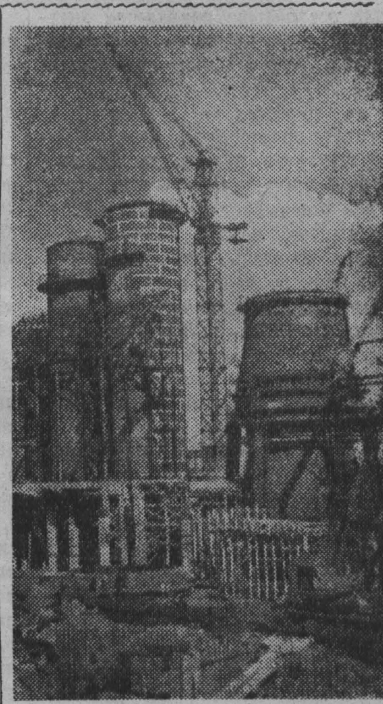
Темир-Тау. Строительство домного комплекса на «Казахстанской Магнитке». Фотохроника ТАСС.
