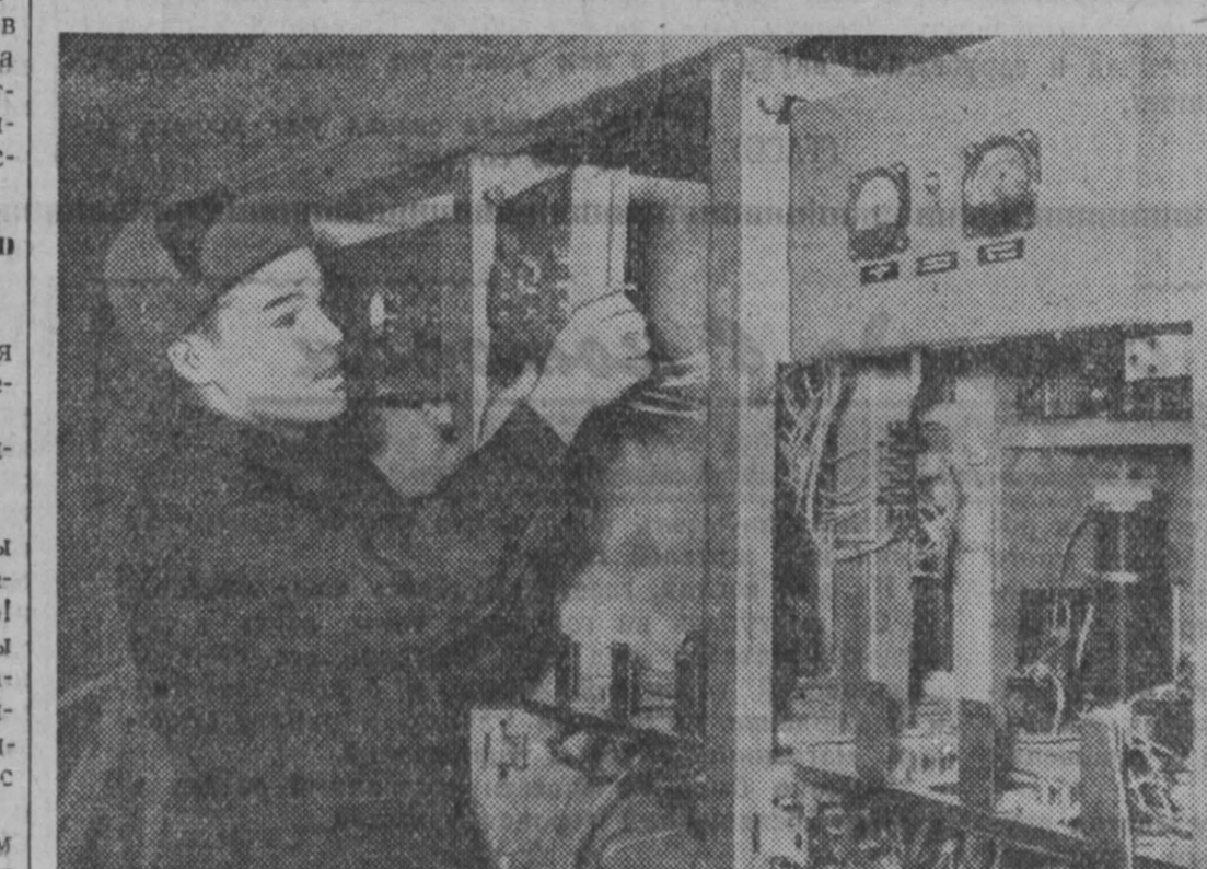
Юрий ГОРДЕЕВ за монтажом выпрямительного щита на Кемеровском телевизионном центре.
