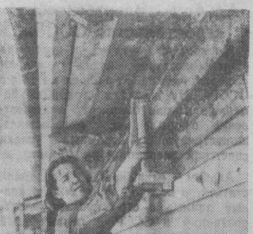
На стройку Западносибирского металлургического завода наряду с молодыми строителями прибыли и кадровые строители. В передовой бригаде штукатуров строительного № 5 треста «Сталкиспром» Л. Вагу трудятся учащиеся Семена Сергеевича Бинурова и Ульяна Семеновна Редкина. Они хорошо справились с заданием, систематически перевыполняют нормы выработки.
