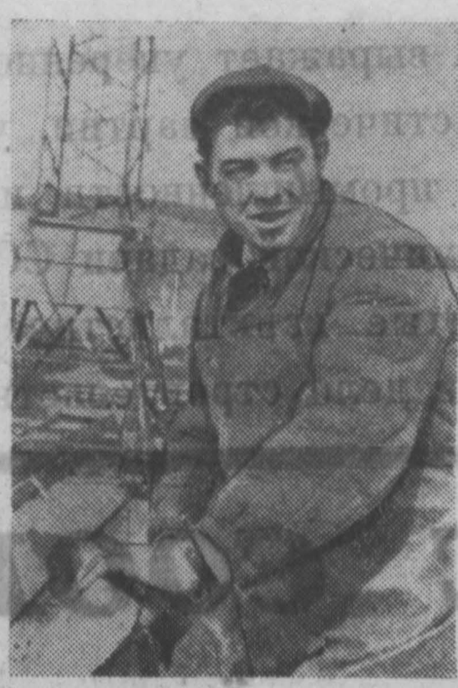
Бригада каменщиков строительного управления № 2 треста «Кемеровоцентрострой», которой руководит Б. Репа, трудится на возведении жилого здания по улице Весенней. Она ежедневно укладывает по два с половиной кубометра кирпича на каждом рабочем. Кладка пятого этажа будет закончена в середине июня. Особенно хорошо работает Георгий Агеев, выполняющий в смену по две нормы.
