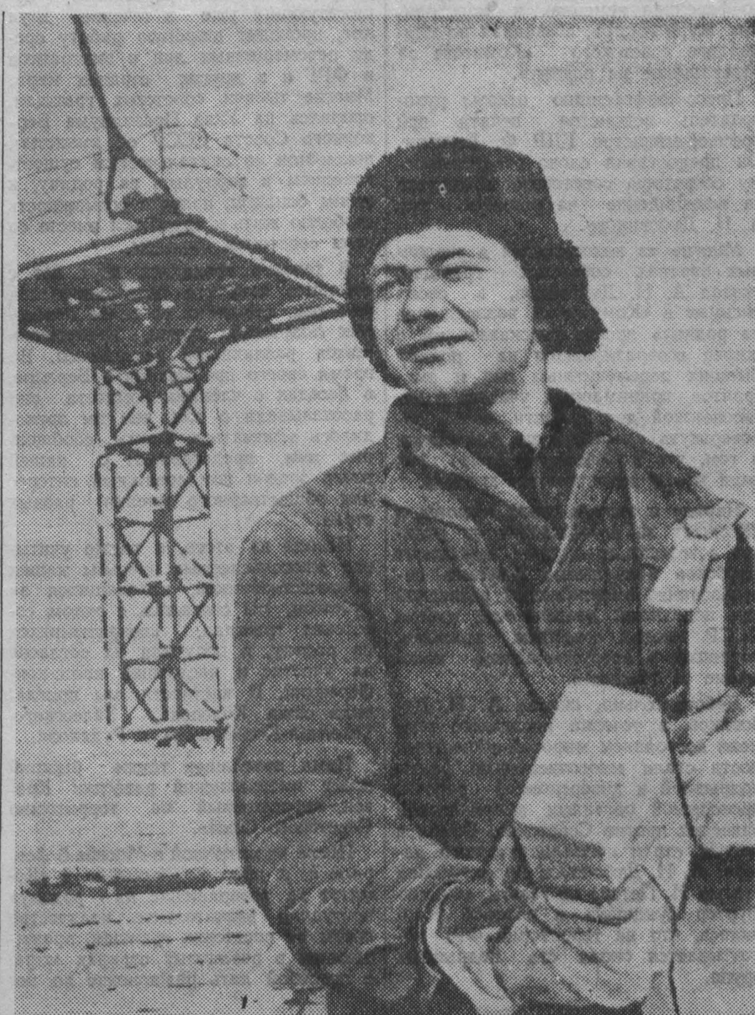
Комсомолец Николай Косачев недавно окончил курсы повышения квалификации каменщиков. Как опытного рабочего его назначили бригадиром. Сейчас бригадир т. Косачев одна из лучших в стройуправлении «Черкасов Камень» треста «Прокопьевскшахтострой». На кладке здания технического училища члены бригады выполняют по две нормы в смену. Николай Косачев повышает свое образование, в этом году заканчивает восьмилетний класс вечерней школы рабочей молодежи.
