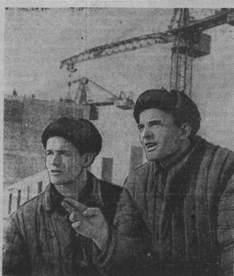
Владимир ЧУХОВ (слева) и бригадир монтажников И. С. БЛИЗНИКОВ.
