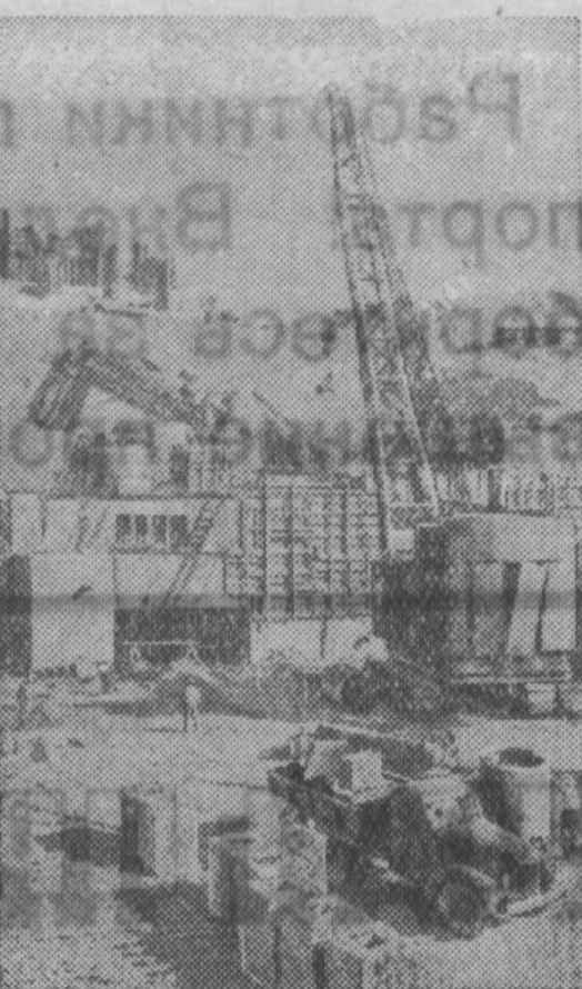
Картагандинская область. В Темир-Тау развинулось сооружение основных объектов казахстанской Магнитки. Заключена подготовка котлованов для домовой печи. Строителям предстоит до конца года уложить в фундамент первой дома 2.100 кубометров бетона. Полным ходом идет строительство коксохимических батарей. НА СНИМКЕ: подготовка котлована для оснований строителей труб коксохимических батарей. Фотохроника ТАСС.
