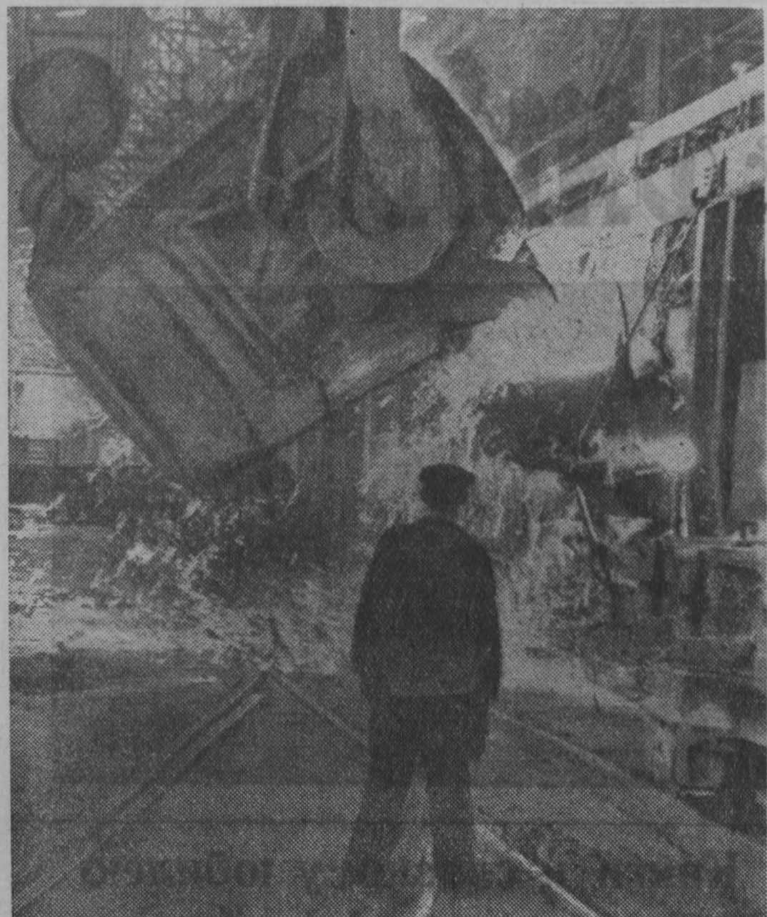
Разливка стали в мартеновском цехе Кузнецкого металлургического комбината.
