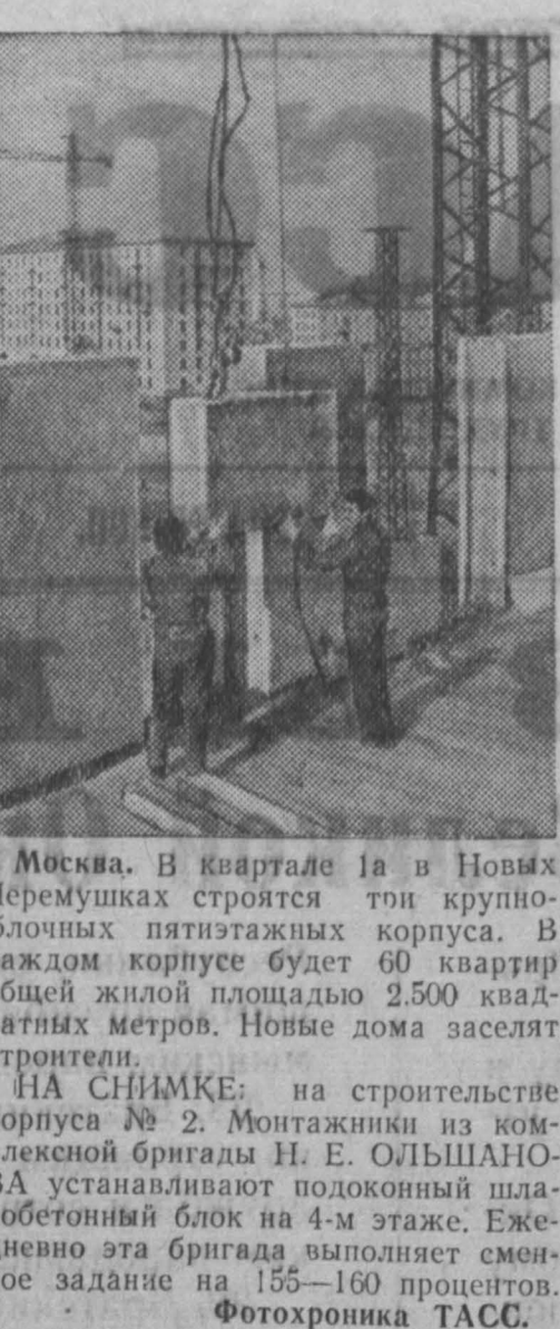
Москва. В квартале Ia в Новых Черемушках строятся два крупноблочных пятиэтажных корпуса. В каждом корпусе будет 60 квартир общей жилой площадью 2500 квадратных метров. Новые дома заселят строителей.
